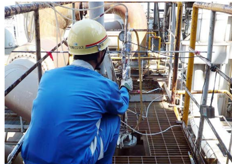
煙道での排ガス測定作業の様子
