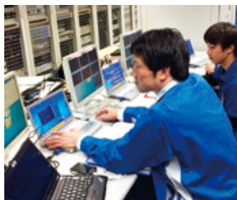
構築作業風景
