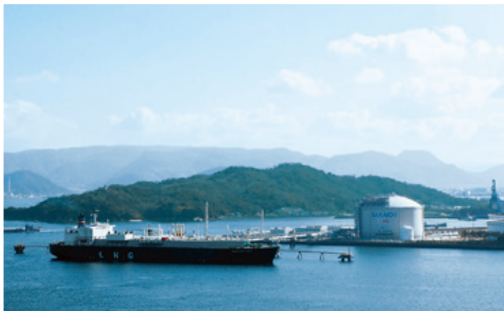
坂出LNG基地
