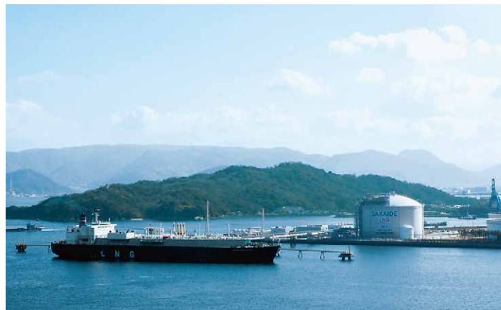
坂出LNG基地
