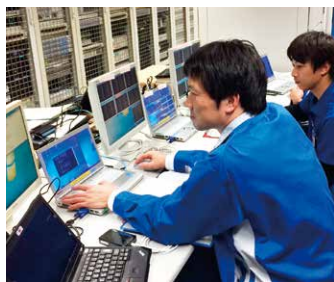
構築作業風景
