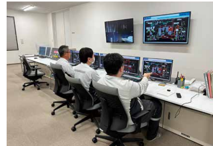
バイオマス発電所の運転業務
