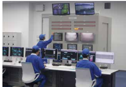
火力発電所環境保全設備の運転業務
