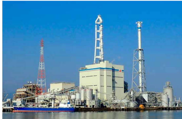
四国電力株式会社西条発電所
