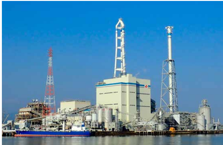
四国電力株式会社西条発電所
