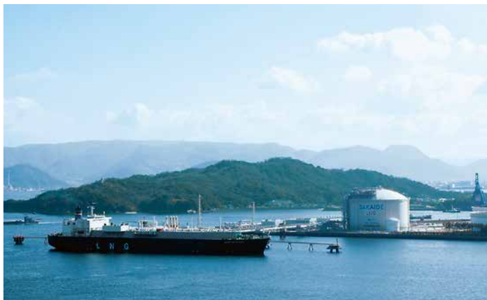
坂出LNG基地
