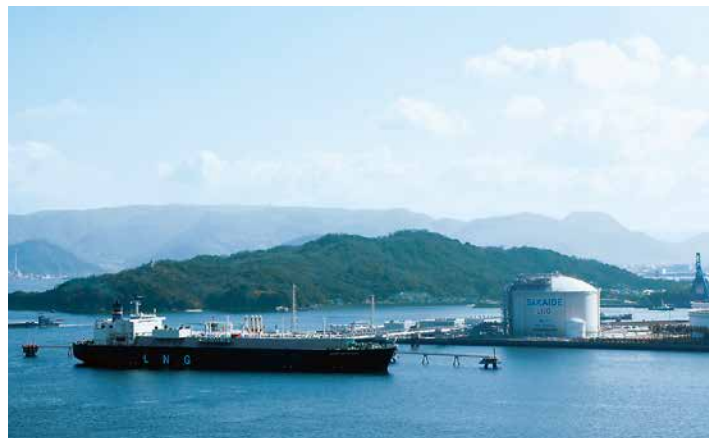
坂出LNG基地
