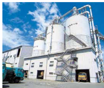
フライアッシュ払出設備
