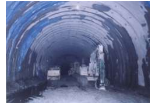
吹付けコンクリート施工状況
