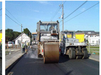
転圧状況 (ロードローラー)
