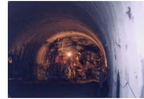
トンネル切羽付近の状況
