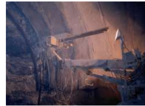
吹付けロボット
