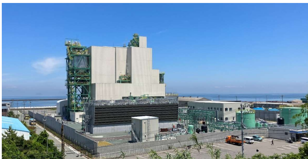
（大洲バイオマス発電所 全景）
